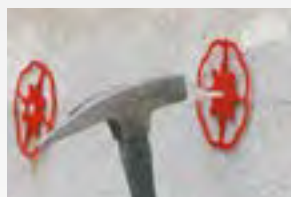
Τα αγκύρια Baumit StarTrack τοποθετούνται στις διανοιγμένες οπές
