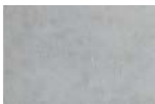
Τεχνική λείας όψης σκυροδέματος
