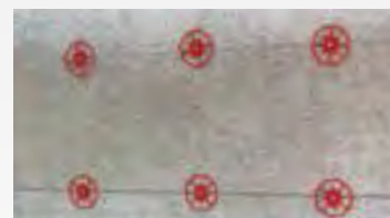
Τα αγκύρια Baumit StarTrack τοποθετούνται σε κάναβο διαστάσεων 40 x 40 cm.
